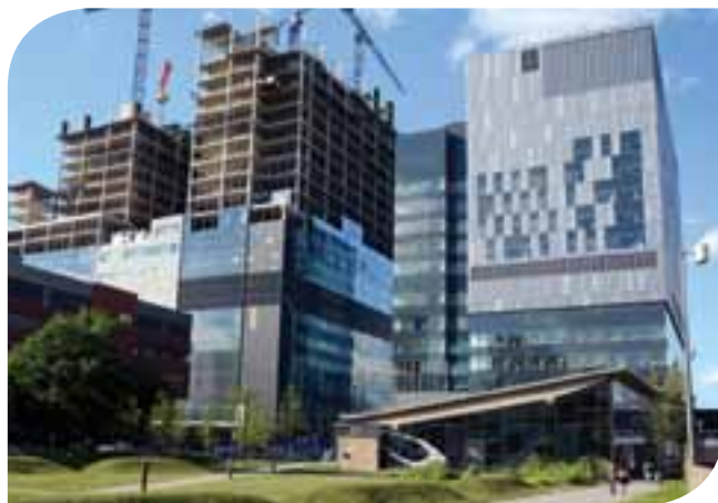
CHUM en construction.
